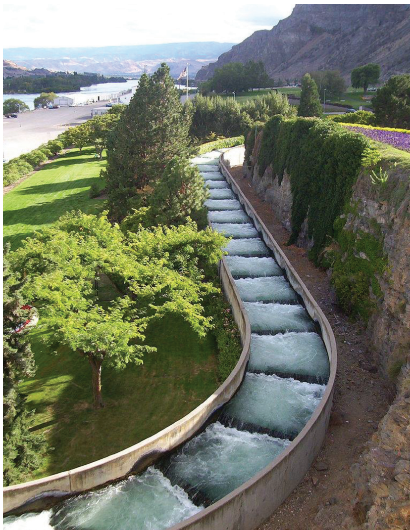
Figura 3. Escalera para peces en una represa en Estados Unidos (tomado de Wikipedia).
